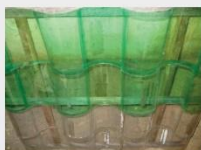
TELHADO EM PET
