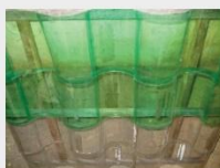
TELHADO EM PET
