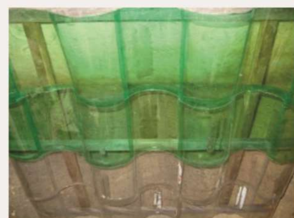
TELHADO EM PET
