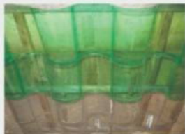
TELHADO EM PET
